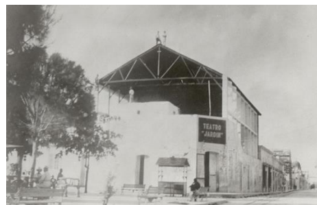
Figura 1 Exterior del teatro jardín en construcción. 1933.
