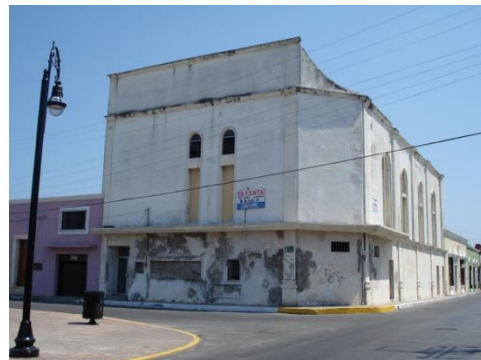
Figura 5 Estado actual del edificio, antes de las intervenciones
